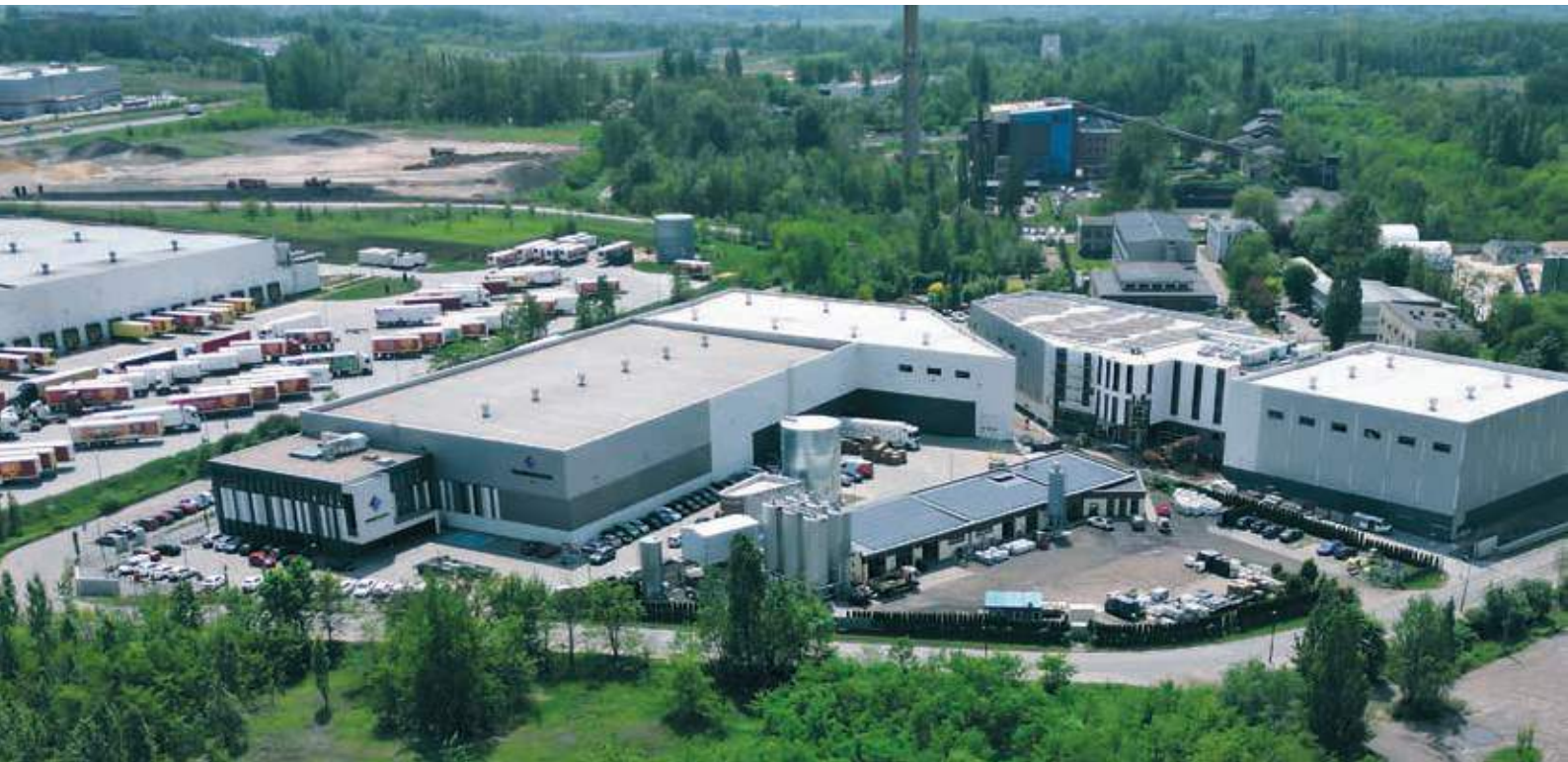
Widok siedziby firmy Thermosilesia sp. z o.o. sp. k.
